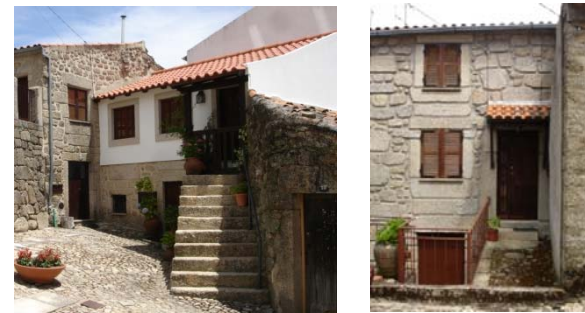
Imagen 4 – Intervenciones de revestimiento de fachada y abertura de ventanas
