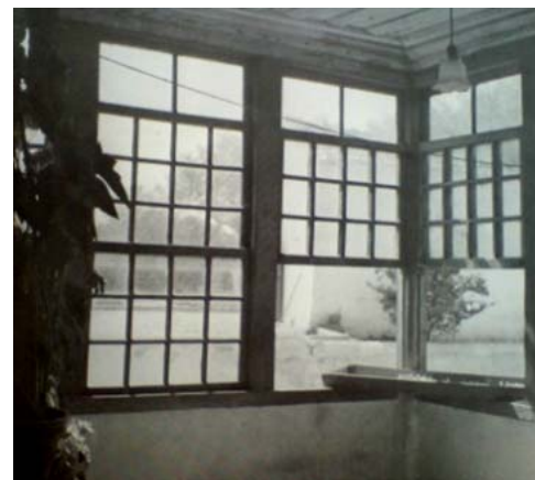
Imagen 36 – Balcones revestidos a vidrio [2]
