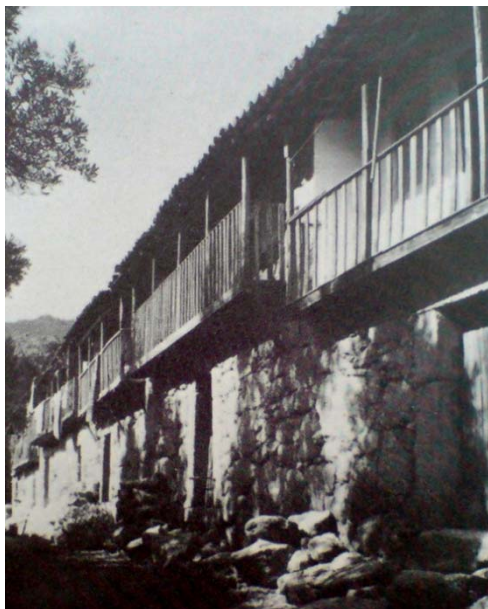
Imagen 35 – Balcones en Castelo Novo [2]
